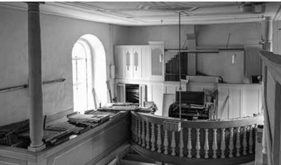
Blick auf die Orgelbaustelle
