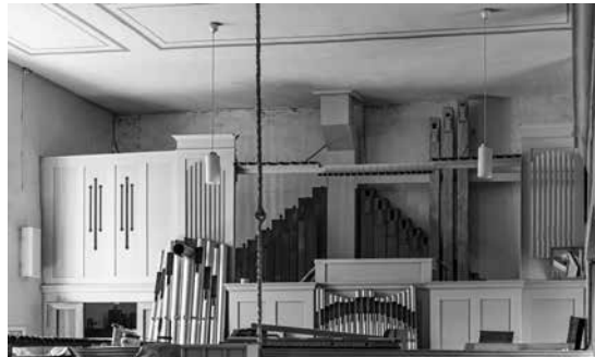
Die Arbeiten an der Lichtenhainer Orgel haben begonnen
